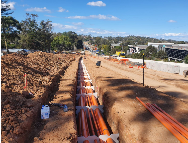
Image: Installing deep trench 33kV conduits
